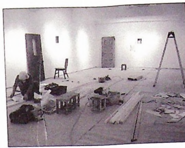
2007年7月に開催された、TWS-Emerging074 池田拓馬「THE OPENING IN THE WALL」のための設営風景より。
